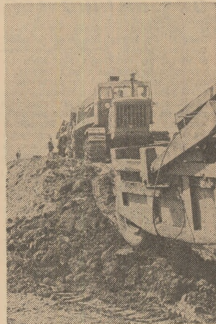
Asemănătoare căpcăunilor din poveste, screperile „mușca“ zilnic zeci de metri cubi de pămînt. Cu ajutorul lor a fost săpat și canalul de aducțiune CA 2 (în fotografie) din marele sistem de irigații de pe Valea Carasu.
