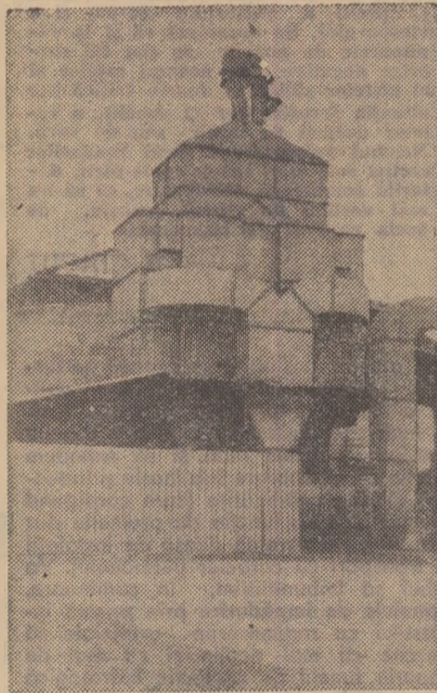
Noul uscător de cereale construit la baza de recepție din Rupea are o capacitate de 150 de tone în 24 de ore. La proiectarea și construirea lui s-au realizat economii de peste 1 milion de lei.
