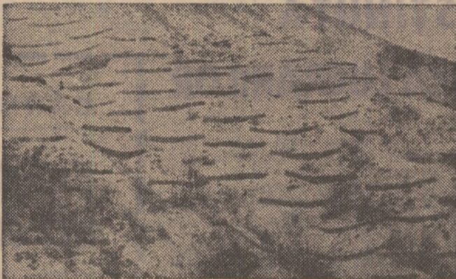
Terasa sprijinită de gardulețe de coastă în terenuri degradate din perimetrul Sibiciu, la ocolul silvic Pîrscov
