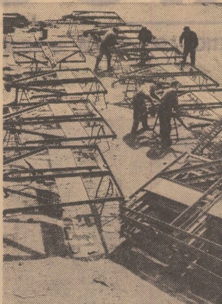
Imagine de la Uzinele de construcții metalice și mașini agricole Bocșa. Se lucrează la confecționarea platformelor pentru discutoare.
