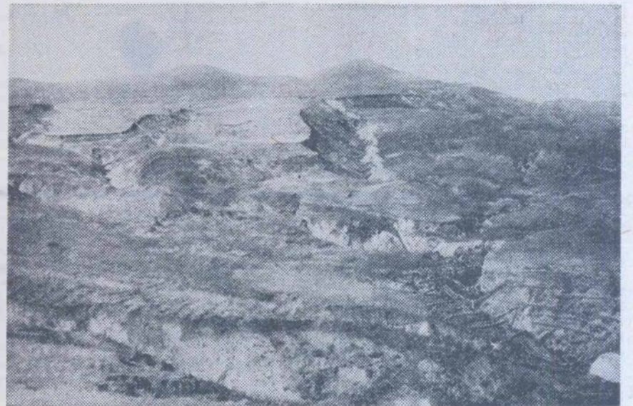
INAINTE... Vedere de ansamblu a subbazinului Oreavu, din perimetrul Putreda, județul Buzău, la începutul lucrărilor de ameliorare
