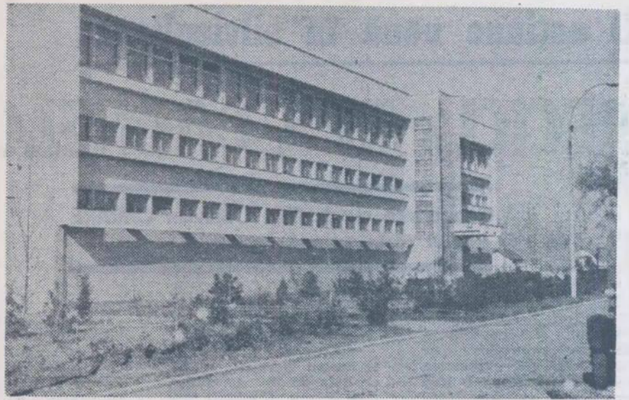
Vedere generală a Uzinei de reparații Balș.
