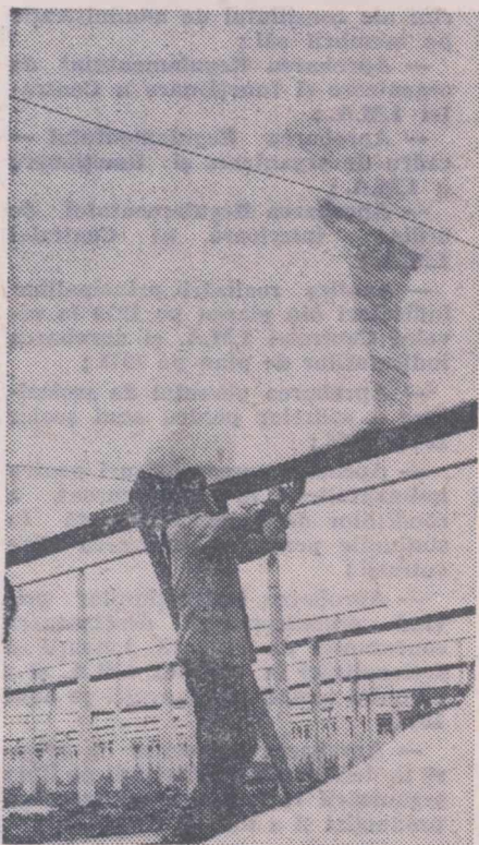
La asociația Intercooperativă Băleni-Dimbovița, în timpul acoperirii solarilor pe ultimele 7,5 hectare. Lucrarea s-a executat cu deosebită grijă pentru realizarea unei etanșeități perfecte.
