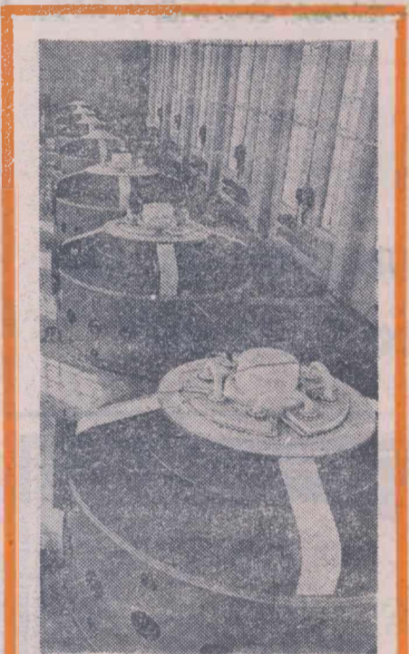
Stația principală de pompare a sistemului de irigații „Engels” (U.R.S.S.)
