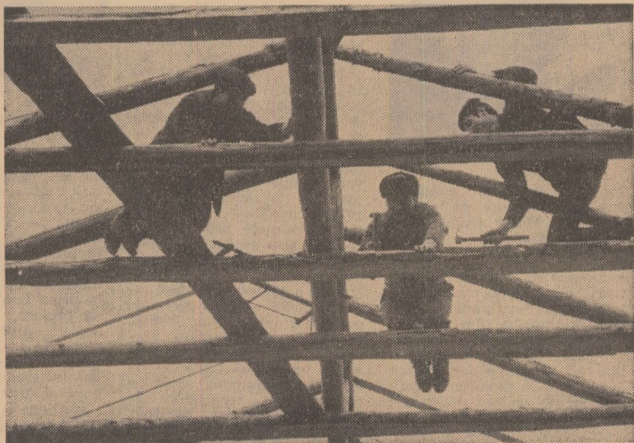
Pentru dezvoltarea zootehnicii, la cooperativa agricolă de producție din Insurăței, județul Brăila, se ridică noi construcții de capacități judicios dimensionate.
