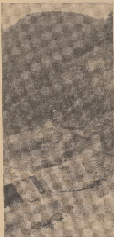
Țîșnind parcă din stîncă muntelui, barajul de la Lesu, județul Bihor, închide valea, stăvilind înaintarea apelor. Aici se va crea un lac de acumulare care va permite, printre altele, irigarea unei suprafețe de 10 000 ha.
