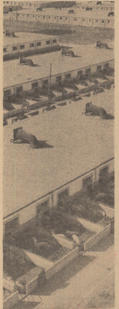
Secvență la întreprinderea de stat pentru creșterea și ingrășarea porcilor — Beregsău, județul Timiș
