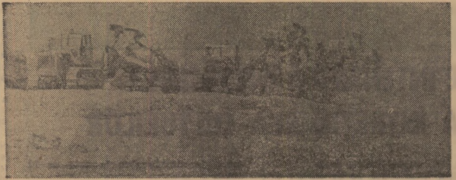
Digurile sunt executate cu utilaje moderne — scurepore de mare capacitate.
