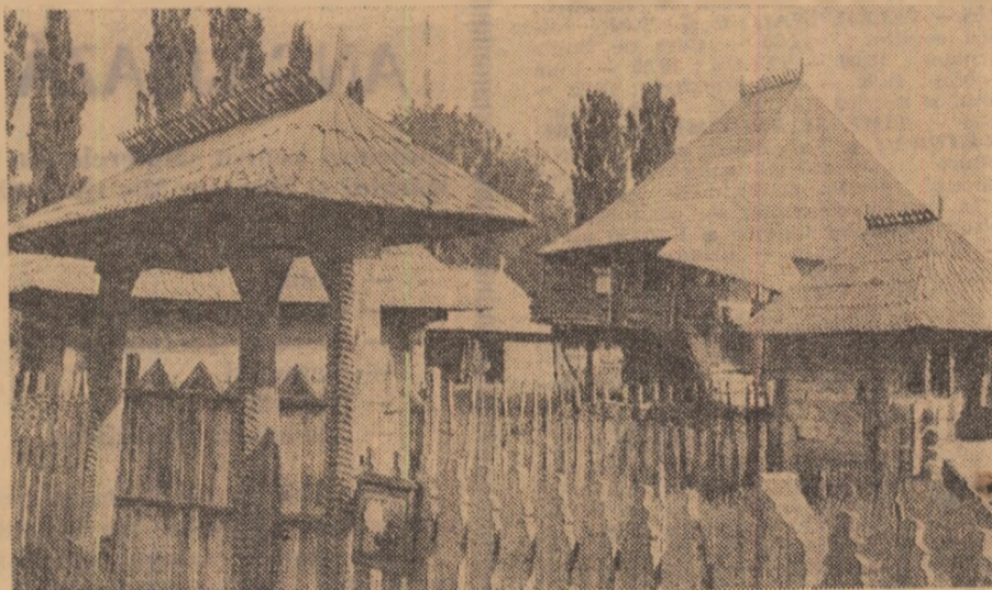
Vedere parțială a gospodăriei din Gorj.
