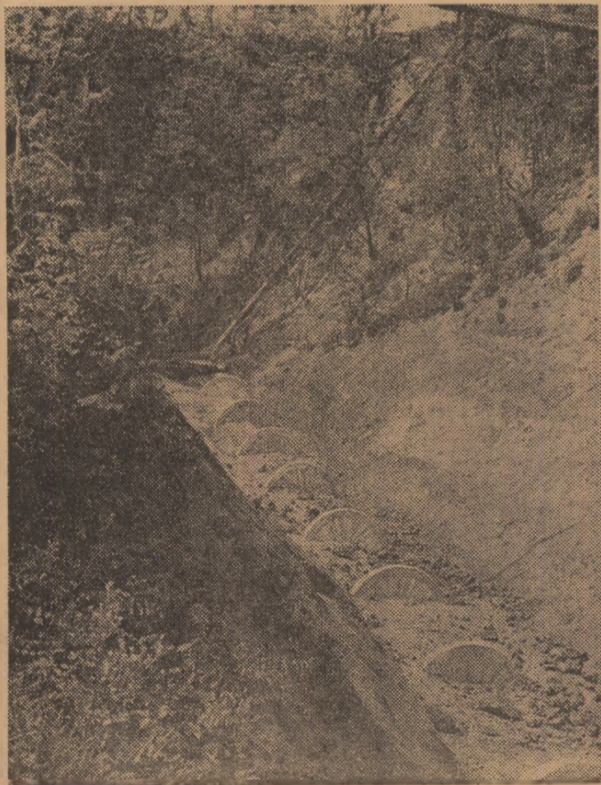
Lucrări efectuate la Poiana Uzului pentru alimentări cu apă. În fotografie: detalii constructive pentru protejarea conductei de apă potabilă împotriva eroziunii și intemperțiilor
