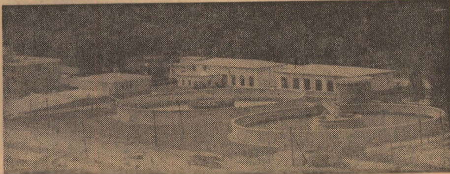
Stația de tratare a apei de la Paltinu; ea este prevăzută, printre altele, cu 12 filtre, instalație de coagulat, bazin de amestec etc.
