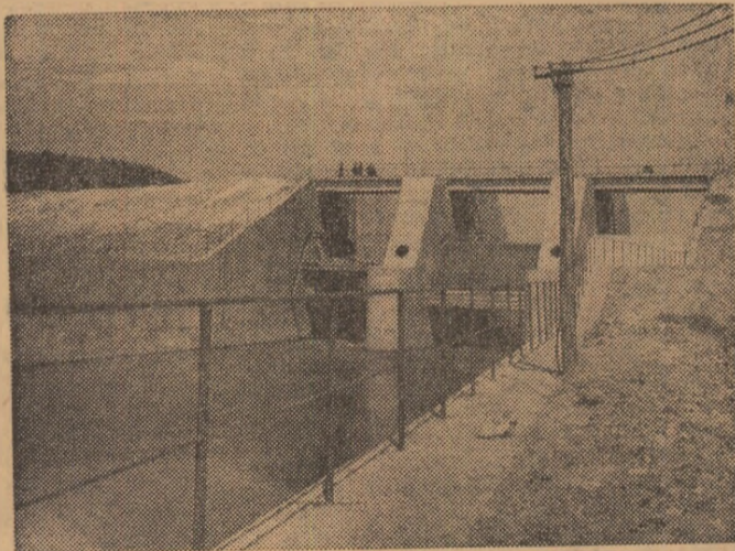
Un stăvilă-eva-cuator construit pe noua albie a Jiului în vederea reglementării debitului de apă și preîntîmpinării inundațiilor
