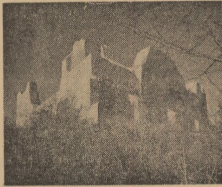
Vedere dinspre sud-est — în timpul lucrărilor de restaurare a Cetății Neamțului
