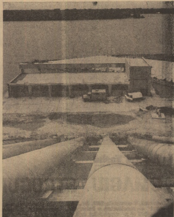
Unul din principalele obiective hidrotehnice ale sistemului Calafat-Băilești, dat în întregime în funcțiune cu doi ani în urmă: stația de pompare de bază de la Basarabi.
