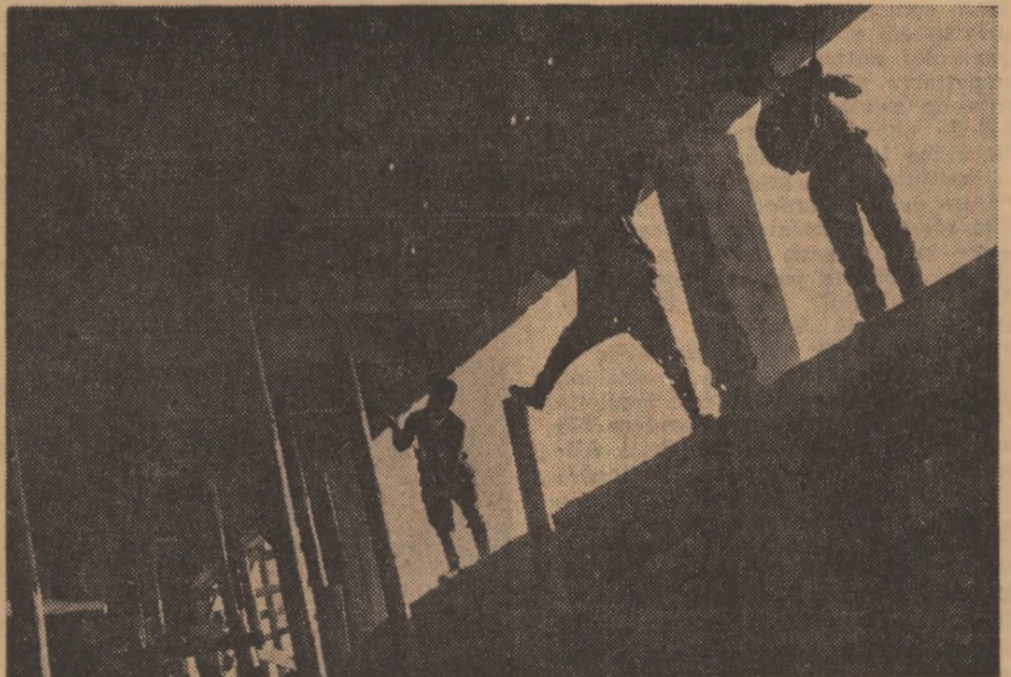
La C.A.P. Maglav, județul Dolj, se construiește un atelier mecanic.
