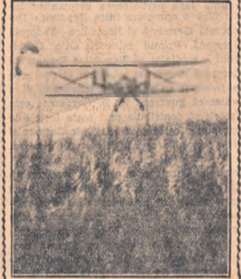
numatarea corpului avionului. Sub arini, avionul are pe fiecare parte cîte 10 duze. Stropirea se face prin intermediul unei pompe aspiro-respingătoare, acționată de o elice.
