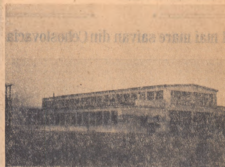
La gospodăria agricolă de stat Cobadin din regiunea Constanța s-au ridicat in ultimii ani noi construcții. In fotografie: atelierul mecanic, in care mecanizatorii au cele mai bune condiții pentru repararea tractoarelor și a mașinilor agricole care vor fi folosite in lucrarea întinselor tarlale ale gospodăriei.
