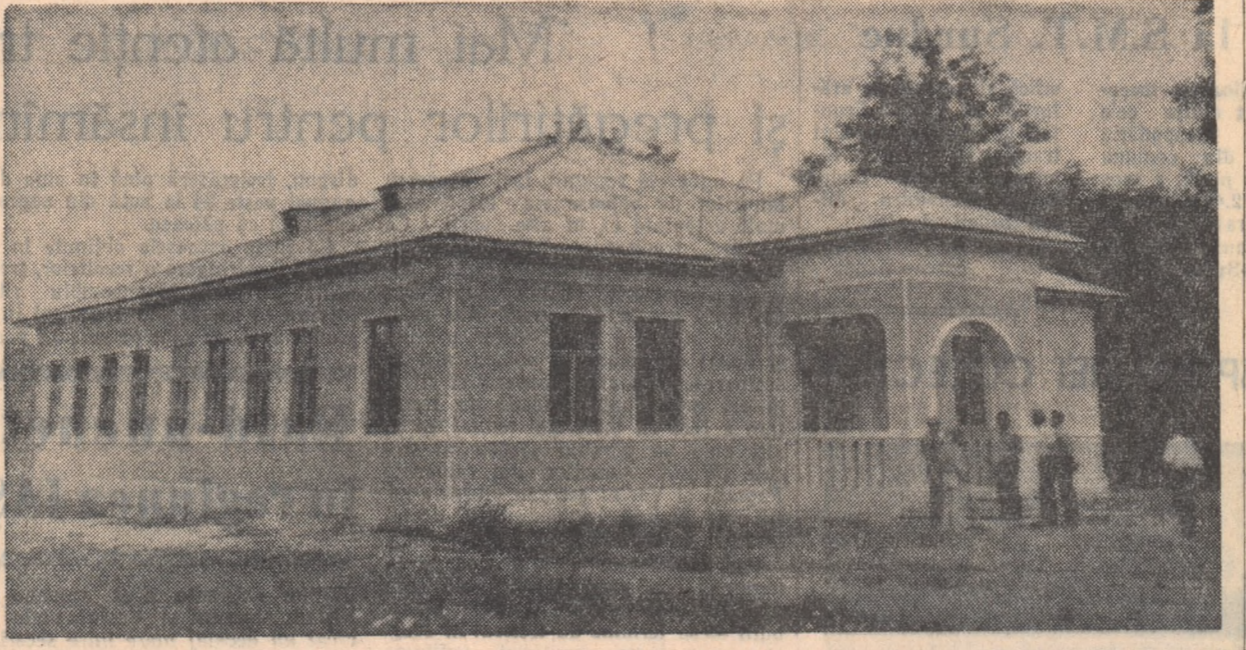
Construit prin autoîmpunere, căminul cultural din comuna Miroși, regiunea Pitești, cuprinde o sală de spectacole, săli de șah, bibliotecă etc. Foto: V. LEUCA
