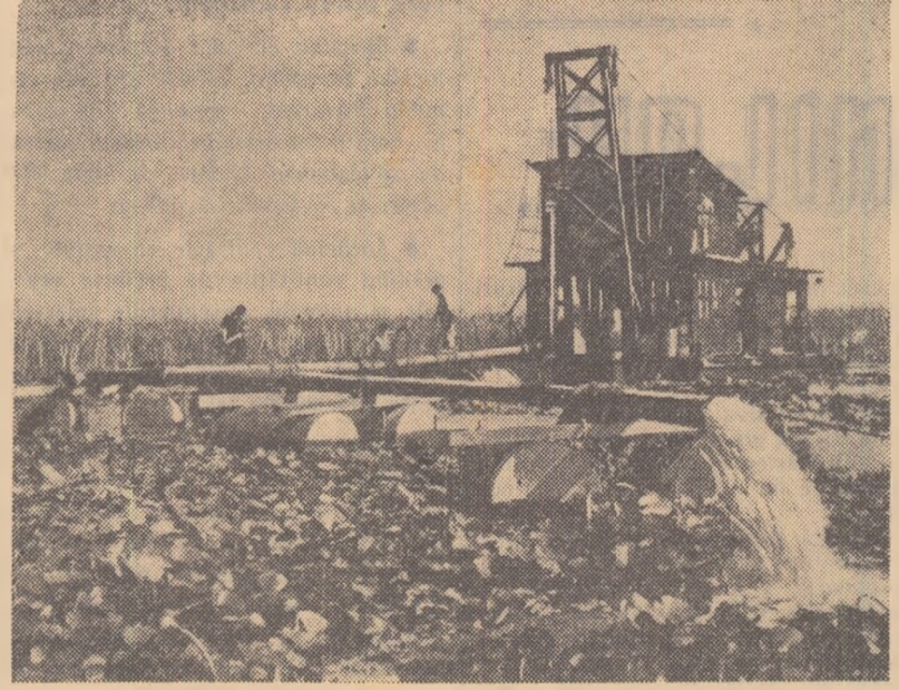
În R. P. Albania se execută mari lucrări de îmbunătățiri funciare. În foto: lucrări de desecări efectuate în regiunea Terbul, cu ajutorul unei puternice drage.
