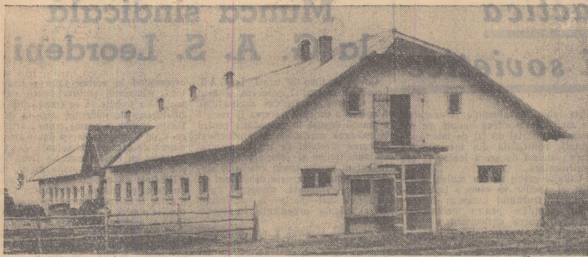
La gospodăria colectivă „7 Noiembrie” din comuna Ștefan Vodă, regiunea București, au fost construite prin munca harnică a colectivității, folosindu-se și resursele locale, multe obiective necesare dezvoltării sectorului zootehnic. În fotografie: grajdul pentru 100 de vaci al gospodăriei.
