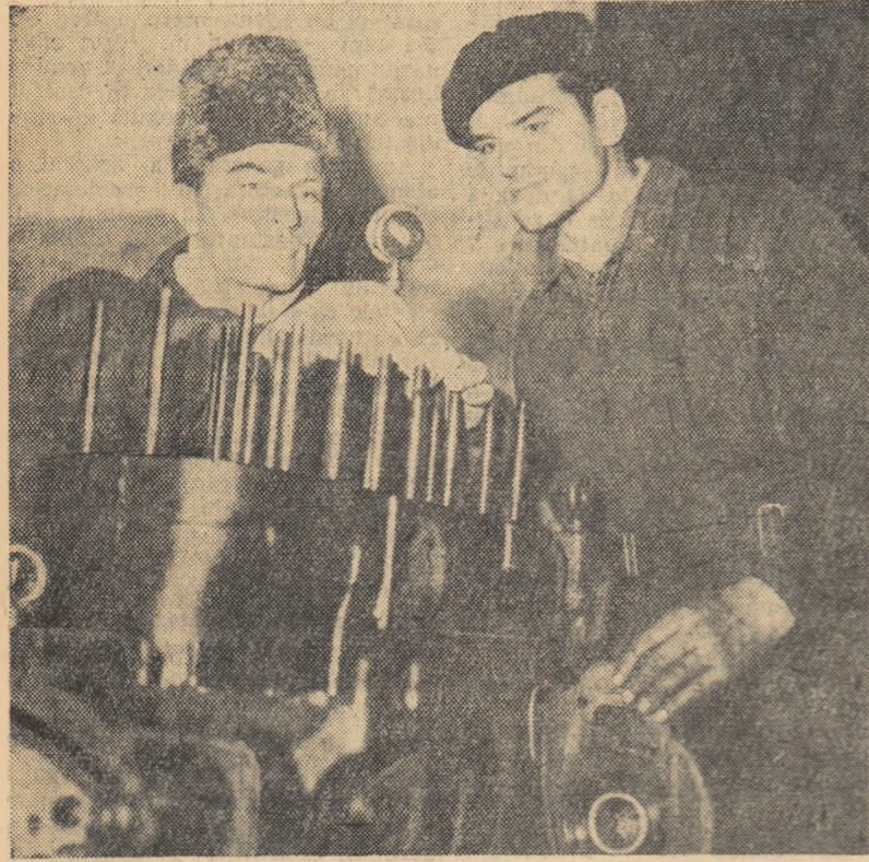
Pină în prezent la S.M.T.-Făurel, regiunea Galați, repararea utilajului agricol a fost efectuată în proporție de 85 la sută. În fotografie: Inginerul Nicolae Hristea și șeful brigăzii a 4-a Ștefan Tănase, efectuând controlul alezajului la cilindri.
