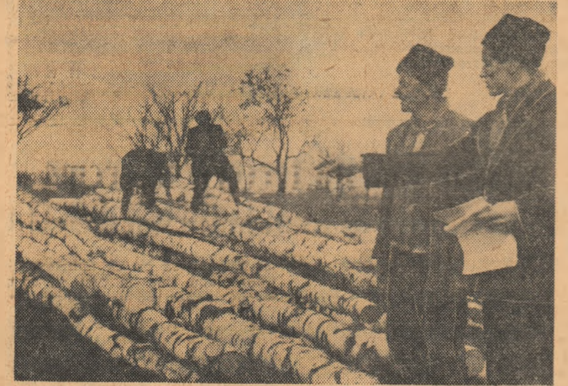
Tinerii colectivști din satul Cosmești, regiunea Iași, se pregătesc din timp pentru construirea de grajduri necesare adăpostirii animalelor. În fotografie: președintele gospodăriei, Toader Miron, împreună cu șeful echipei de construcții, Dogaru Manolache, discută asupra profilor metalului lemnos ce se va folosi în construcții.
