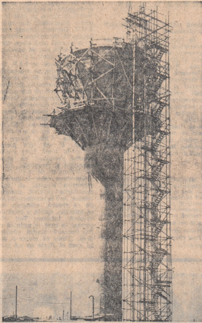
Joc de linii și umbre... Noul castel de apă, aflat în construcție la Combinatul pentru creșterea și îngrijirea porcilor de la Palota, regiunea Banat.
