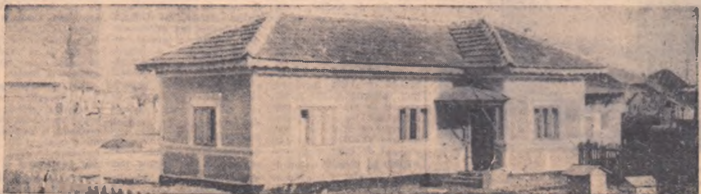
Casa locuitorului B. Dionid, făcută cu credit de la stat. 25 de astfel de locuințe s-au ridicat în ultimii 2 ani în comuna Răcari.
