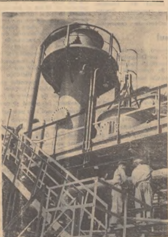
Instalația de gazificare a laminorului de tablă „N. Cris- tea”-Galati
