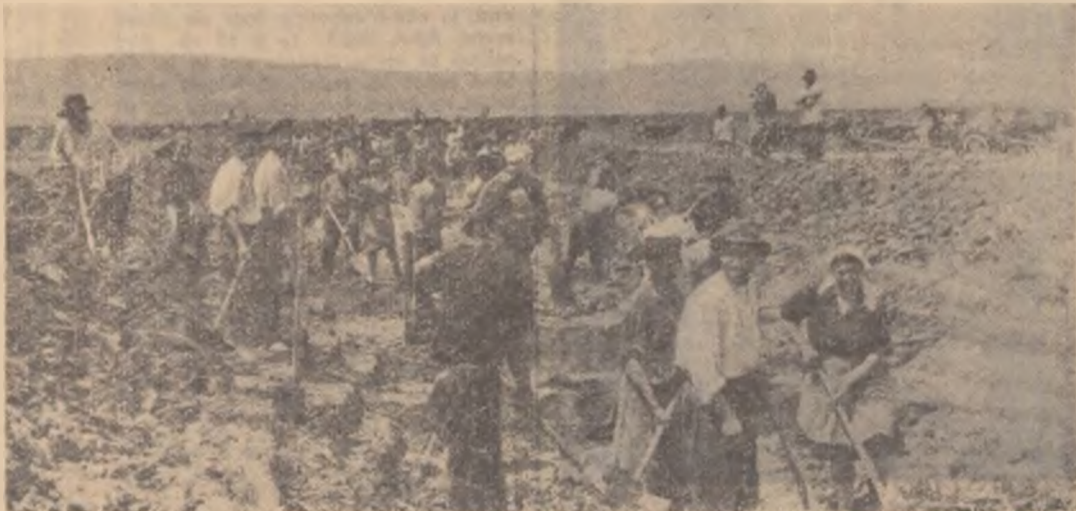
Țărani muncitori lucrînd pe șantierul de la Sarata
