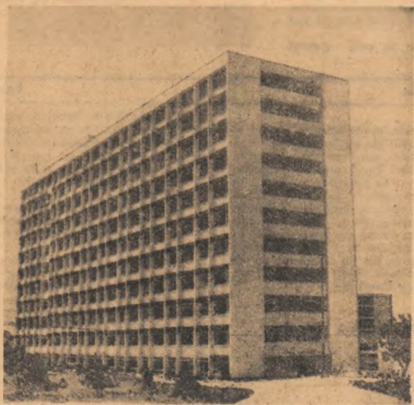
Unul dintre noile blocuri de la Mamaia, la construcția cărora, aplicînd metoda „coțrajelor alunecătoare”, zidarii au executat cite un etaj în 24 de ore
