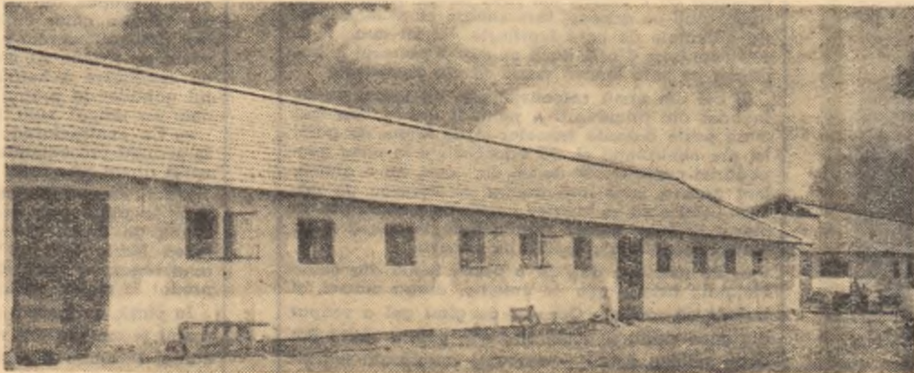
Deși înființată abia în anul trecut, gospodăria colectivă „24 Ianuarie” din Țigănești, raionul Alexandria, dispune de un sector zootehnic dezvoltat. În fotografie: două din grajdurile terminate.
