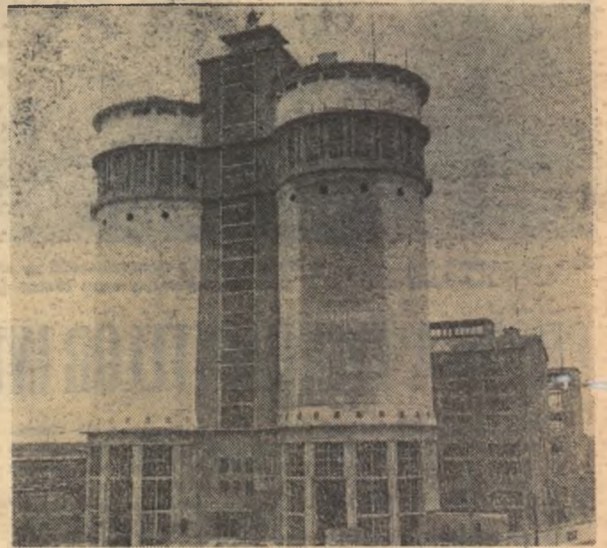
Combinatul de la Roznov. Turnurile pentru granulara azotului de amoniu
