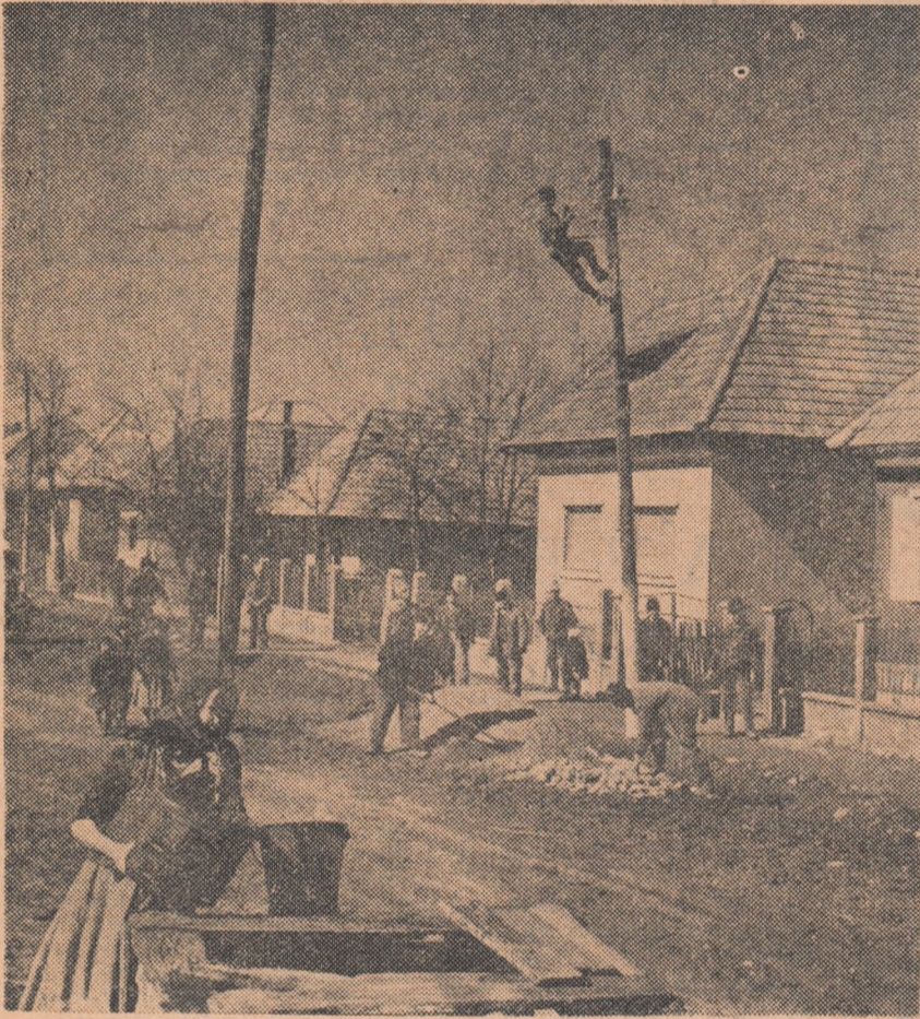
Noi construcții de locuințe ale colectivștilor din comuna Mocira, raionul Baia Mare.
