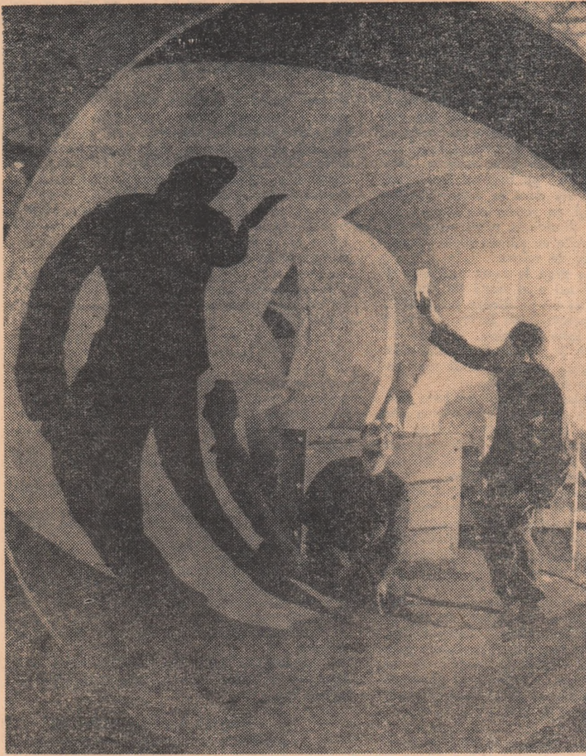
Aspect din secția cazangerie a Uzinelor „23 August” din Capitală.
