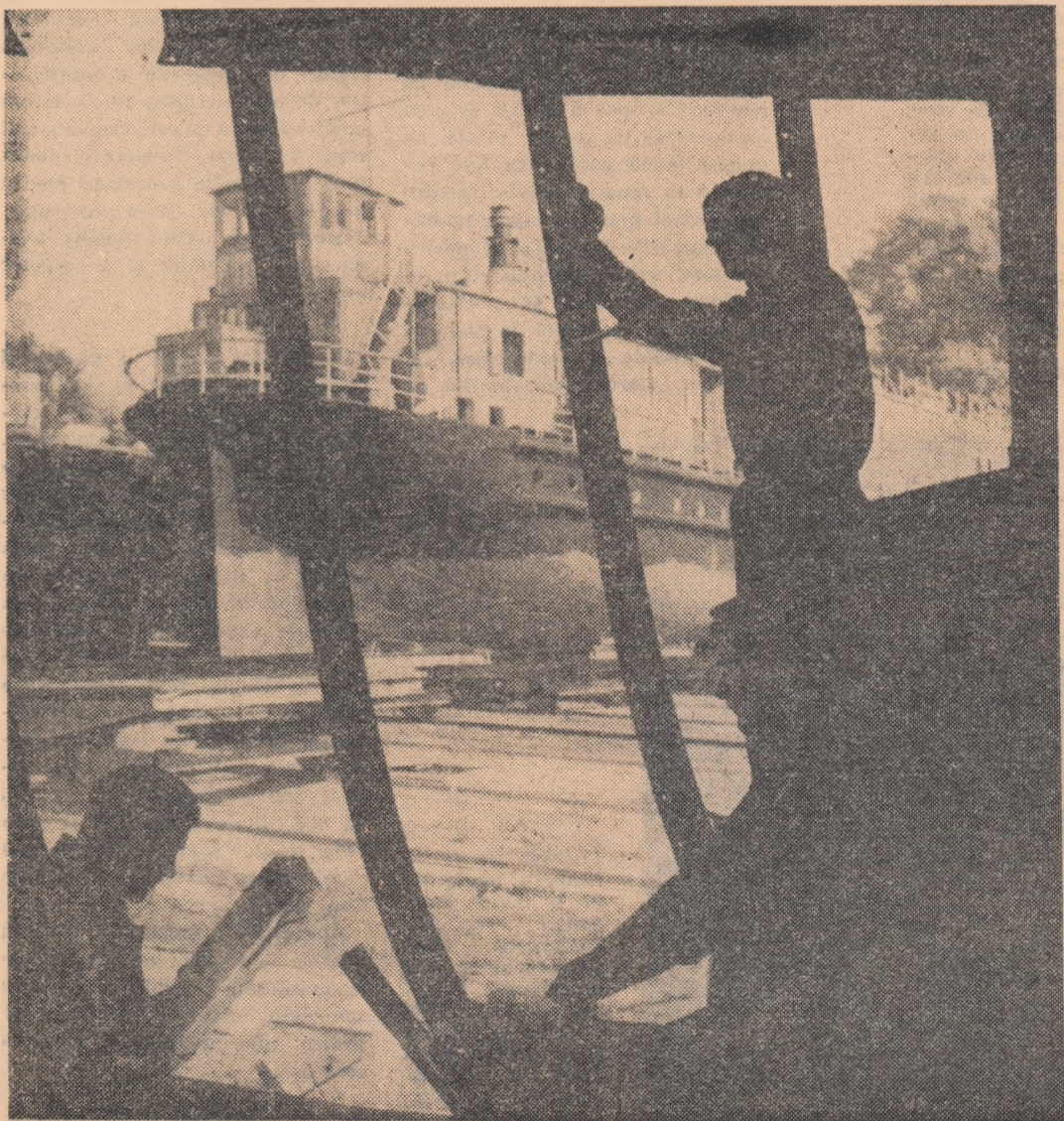
Aspect de la Șantierul naval — Giurgiu
