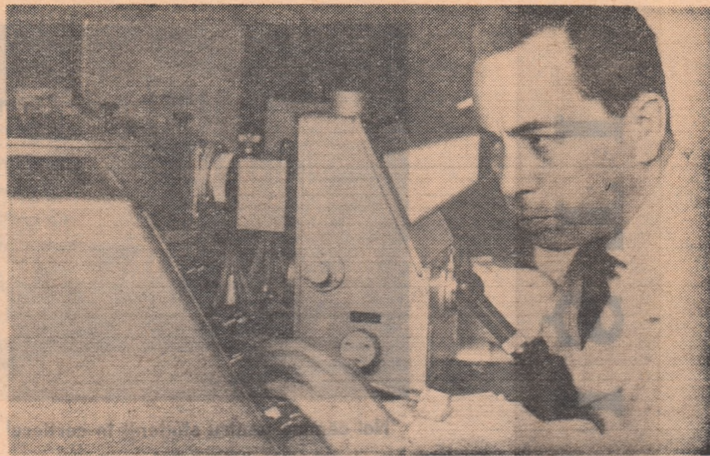
Inginerul Nicolae Hurdac, candidat în științe biologice de la Institutul de cercetări pentru cereale și plante tehnice din Capitală, determină cu ajutorul spectrofotometrului compoziția pigmentilor din rânzele de porumb
