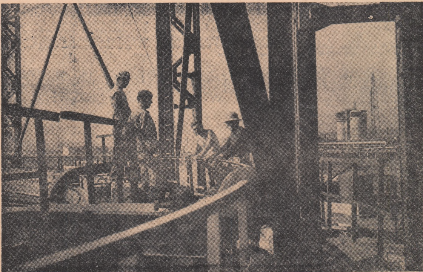
Aspect de la șantierul Combinatului chimic Cralova
