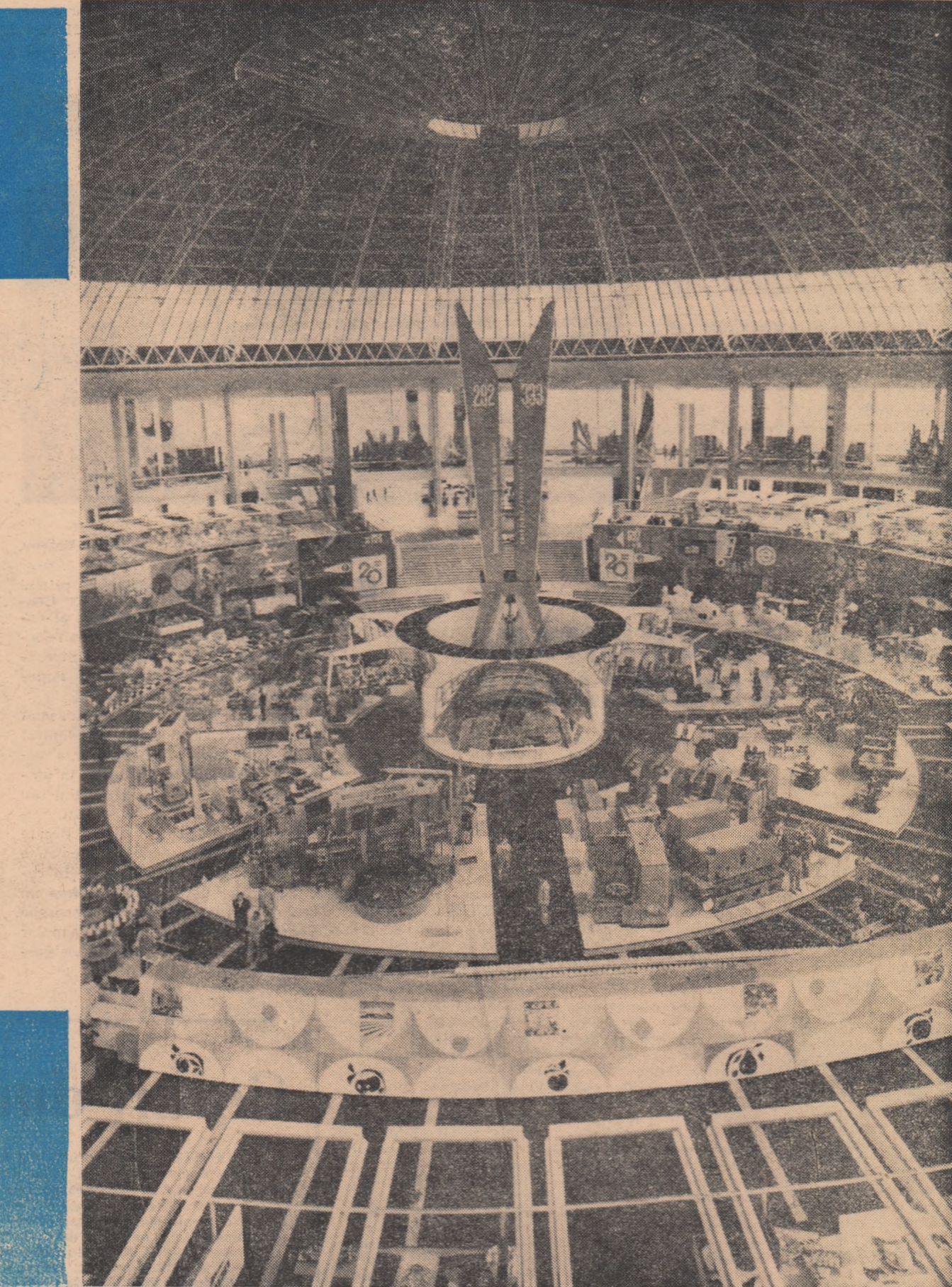
Vedere interioară din Pavilionul central al Expoziției realizării economiei naționale.
