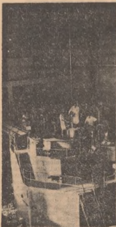
Corpul principal al reactorului atomic de la Institutul de fizică atomică al Academiei R.P. Romine.
