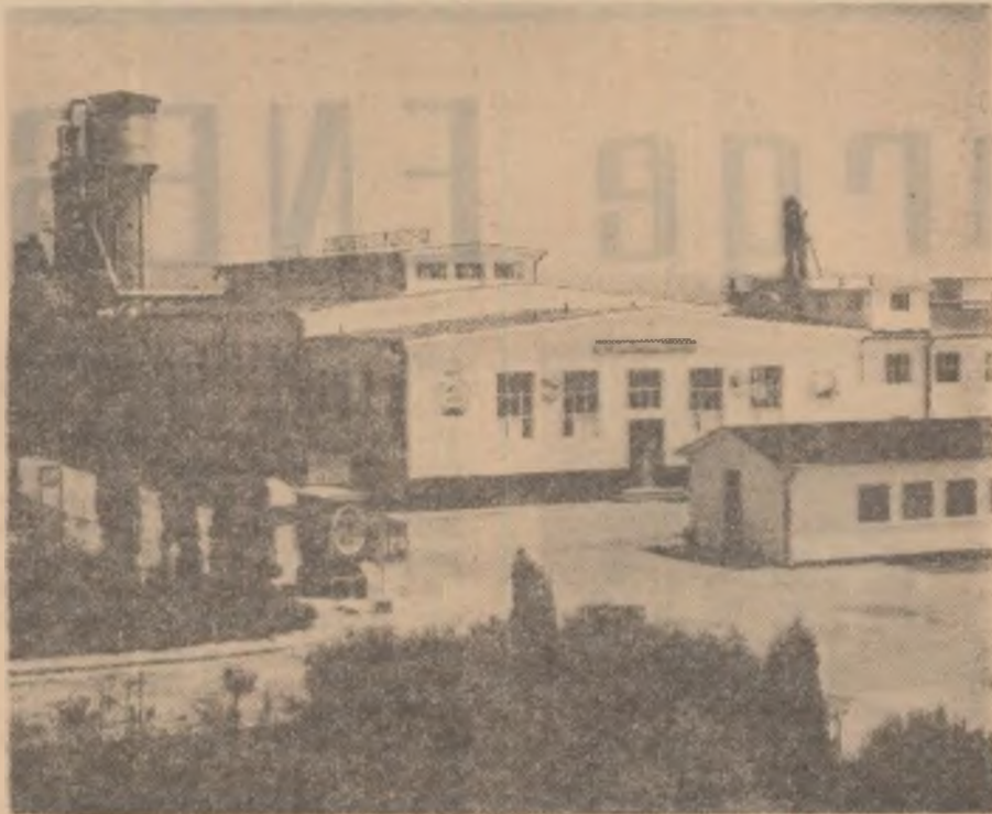
Vedere parțială a fabricii de conserve din fructe și legume din Riureni, regiunea Argeș
