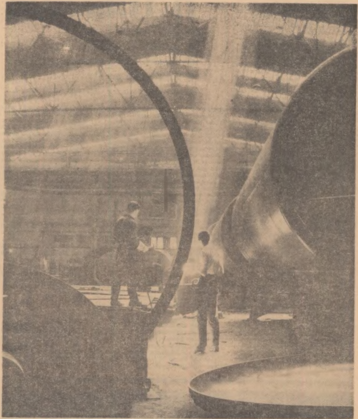
În secția cazangerie, atelierul cisterne al Uzinelor „23 August” din Capitală
