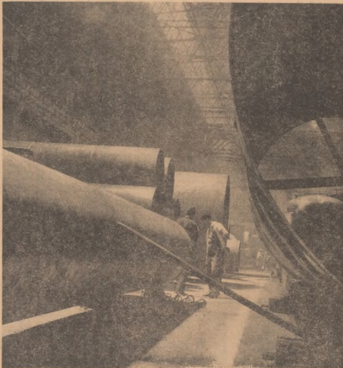
Secția cazangerie a uzinei Vulcan din Capitală. Se lucrează la montarea unor utilaje destinate industriei chimice
