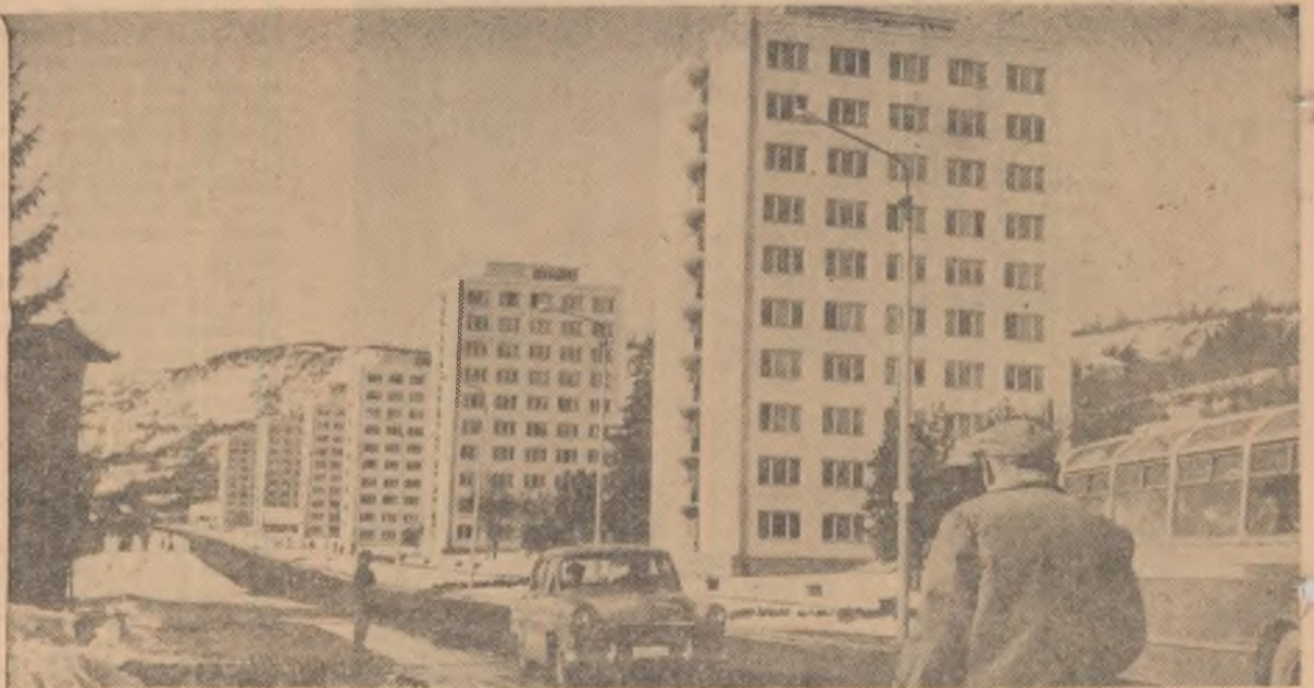
Construcții noi în cartierul N. Grigorescu din Cluj
