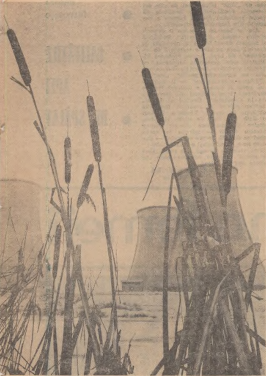
pe malul Mureșului — turnurile de răcire ale Termocentralei Iernut-Luduș
