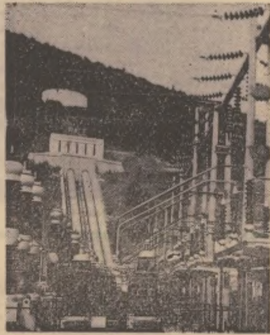
Aspect de la Hidrocentrala Bicaz
