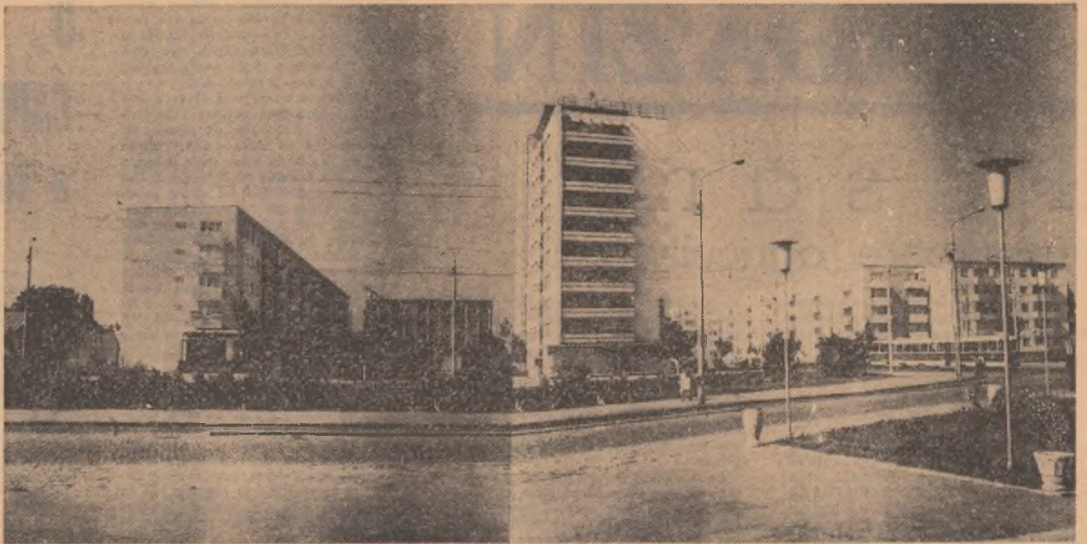
Noi construcții în municipiul Brăila.
