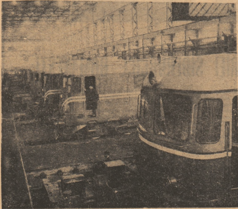
Hala de montaj a uzinelor „Electroputere”-Craiova
