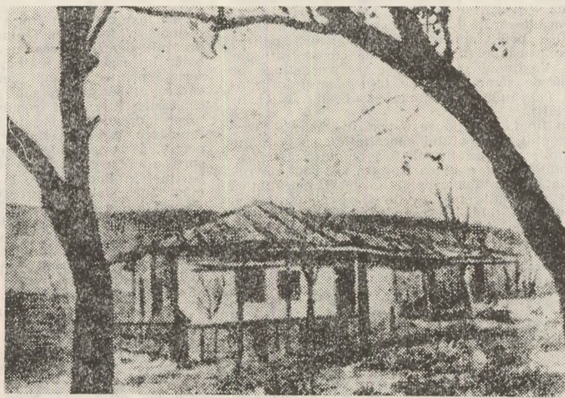
Bojdeuca din Țicău înainte de restaurarea din 1918
