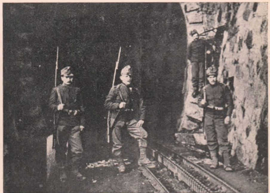
Paza unui tunel. Toate podurile drumurilor de fer, ba și a drumurilor celorlalte, mai ales în părțile pe unde se știe că are de trecut armată, — sunt așa păzite de soldați înarmați. Tot așa tunelele prin cari trec căile ferate, — cum se vede și în chipul de sus.
