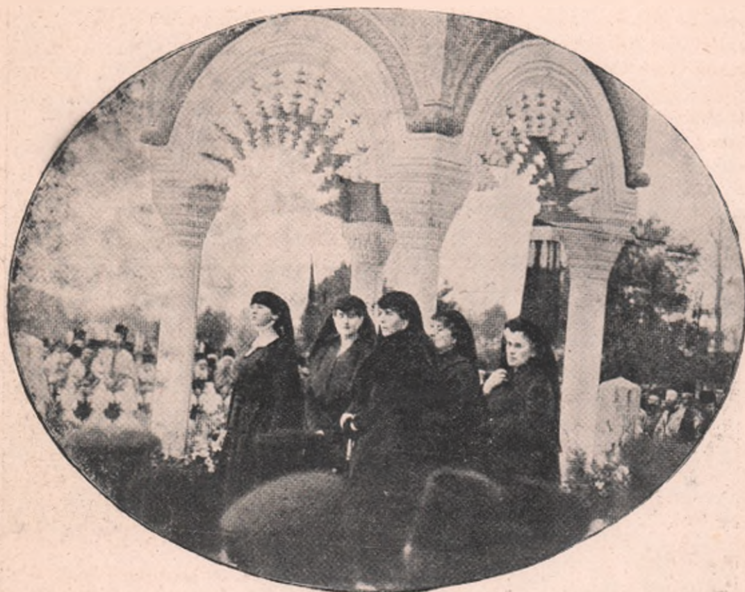
Vedere din minunata Mănăstire dela Argeș, în care a fost așezat spre vecinică odihnă Regele Carol I. al României. Chipul de aci ne arată pe M. S. noua Regină Maria, cu Princesele Elisaveta și Maria (cele 3 dinainte) luând parte la prohodul asupra Regelui Carol în mănăstire.
