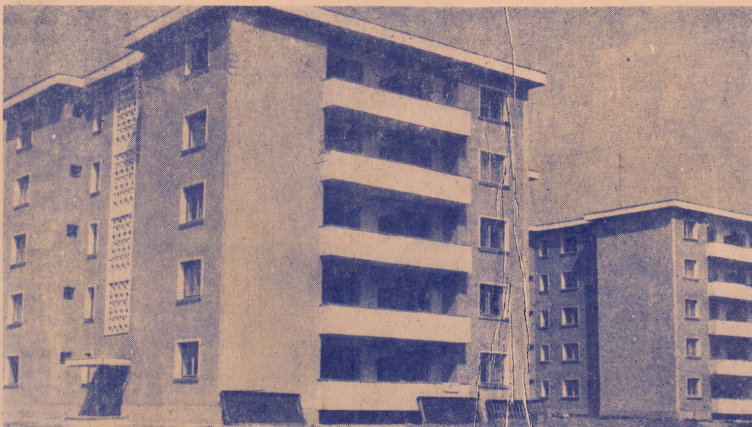
Bloc S—1 cartier Tătărași confort I, cu apart. 2, 3 camere, cost mediu 67.000 lei și 81.000 lei.
