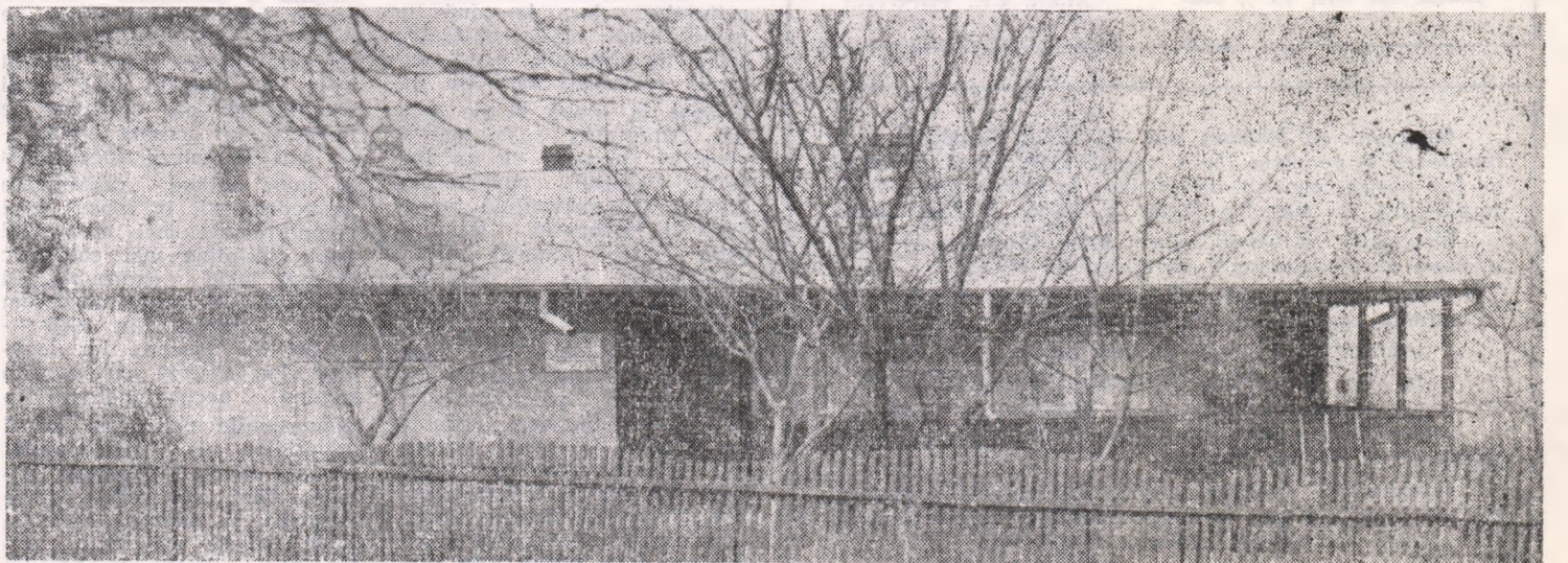
Casa din Vlădiceni unde a funcționat o tipografie ilegală
