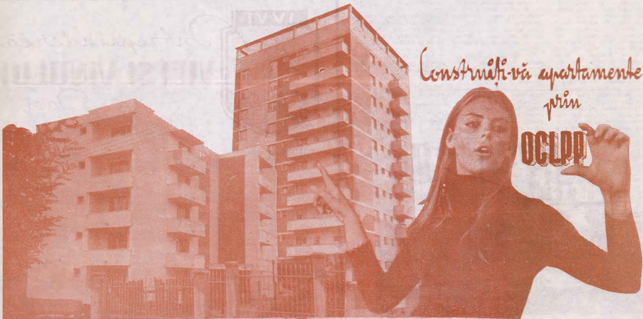
Imagini ale unor blocuri proprietate personală din orașul Iași.
