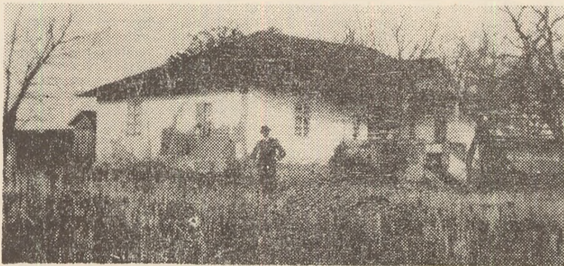
Casa de la Ipotești, dărîmată în 1924
